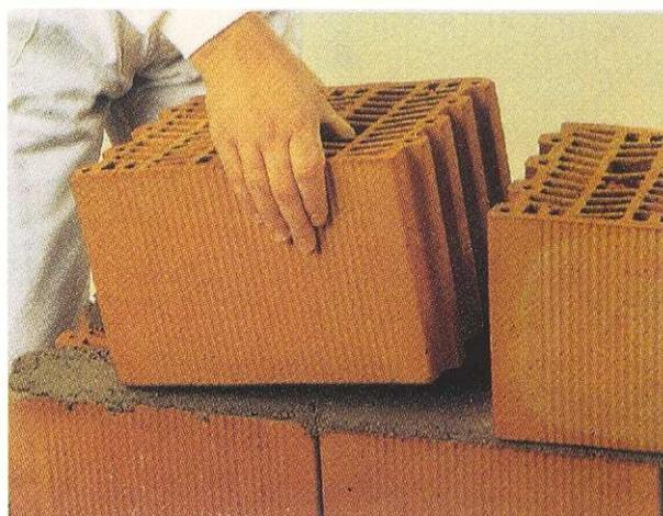
4.º Los bloques se colocarán sin mortero en la junta vertical.
