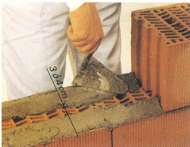
3.º Con objeto de interrumpir el puente térmico provocado por la junta horizontal, ésta deberá ser discontinua. Para ello el mortero se dispondrá en dos bandas separadas por un espacio central libre de 3 ó 4 cm.
